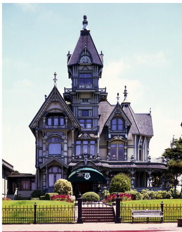
Figure 16: Estilo Reina Ana: la mansión Carson, en Eureka, construida entre 1884 y 1886 para el magnate maderero William Carson. Torre, línea de tejado compleja, tejas decoradas y tracería de madera en una de las fachadas. Fotografía: Archivo de Carol M. Highsmith, Biblioteca del Congreso, División de Grabados y Fotografías (n.º de referencia LC 2011632002).
