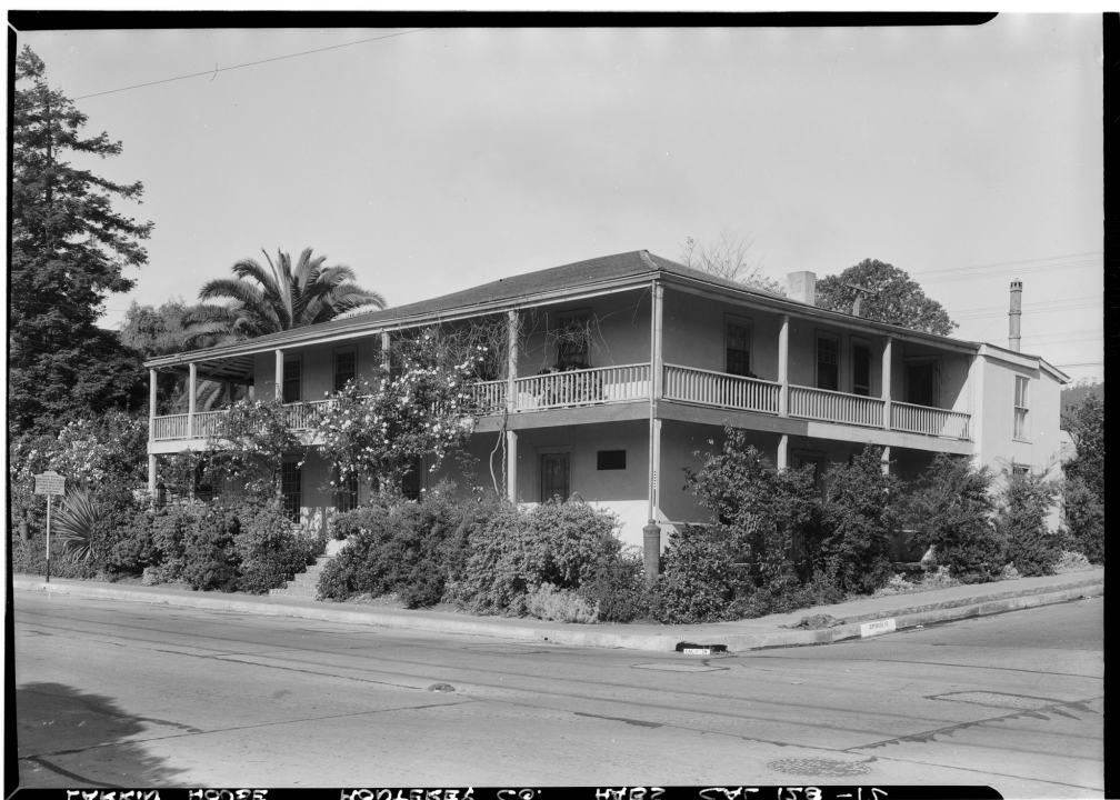
Figure 26: Estilo colonial de Monterey: la Casa Larkin, en Monterey, construida entre 1835 y 1837, el prototipo mencionado anteriormente. Construcción de adobe bajo un balcón que ocupa todo el ancho de la segunda planta. Fotografía: Robert W. Kerrigan, 13 de mayo de 1936. Estudio de Edificios Históricos de Estados Unidos, Biblioteca del Congreso (HABS CAL,27-MONT,9--2).
