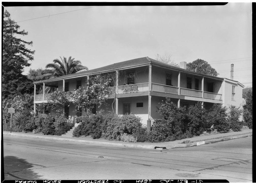
Figure 26: モントレー・コロニアル様式：モントレーのラーキン・ハウス（1835～37 年築）。前述の原型となる建物。2 階の全幅にわたるバルコニーの下に、アドベ造りの構造が見られる。写真：ロバート・W・ケリガン、1936 年 5 月 13 日。『米国歴史的建造物調査』（Historic American Buildings Survey）、米国議会図書館（HABS CAL,27-MONT,9--2）。
